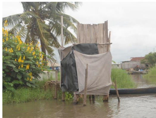
Quelques latrines de fortune installées par la population
