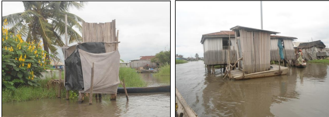
Photo 5 : Quelques latrines de fortune installées par la population à Ganvié (Commune de So-Ava)
