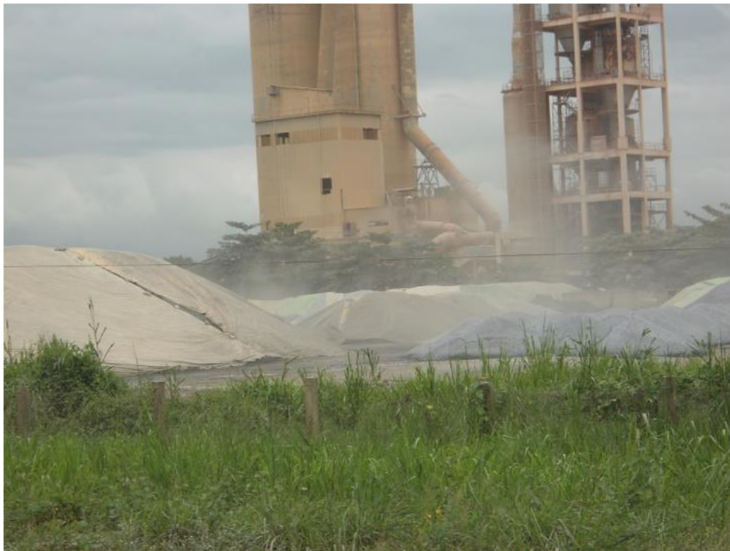
La poussière dans l'environnement de l'usine vue de loin
